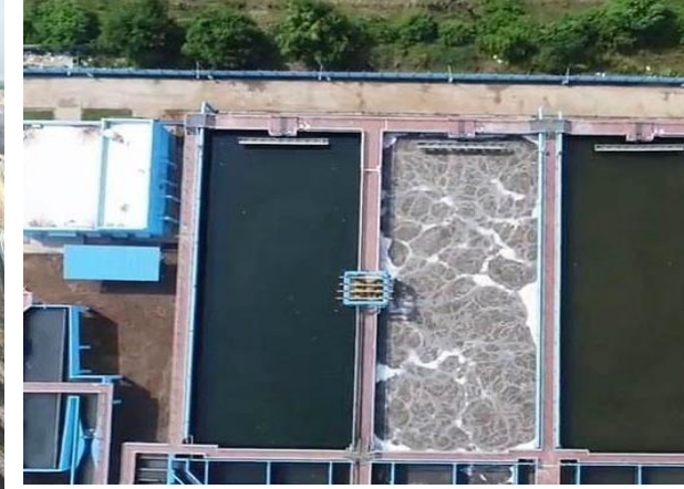
33 MLD STP, Anand, Gujarat
