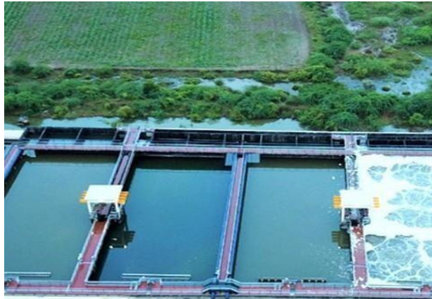
32.3 MLD STP, Surendra Nagar, Gujarat
