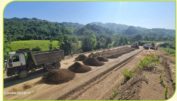
GSB Top Layer Laying @KM 3+400, Myanmar
