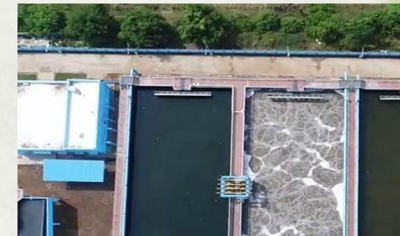
33 MLD STP, Anand, Gujarat
